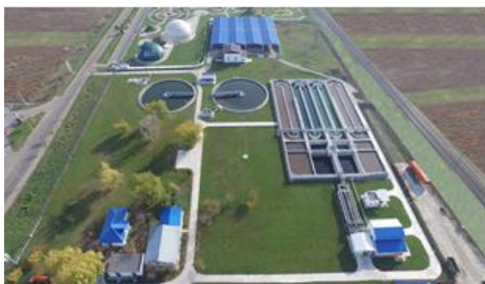
Stația de epurare ape uzate Tecuci
